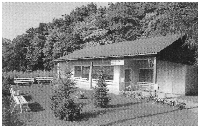
Brunnenhaus, wurde von der Wildsbergquelle errichtet und dem Heimat- und Verkehrsverein zur Nutzung übergeben
