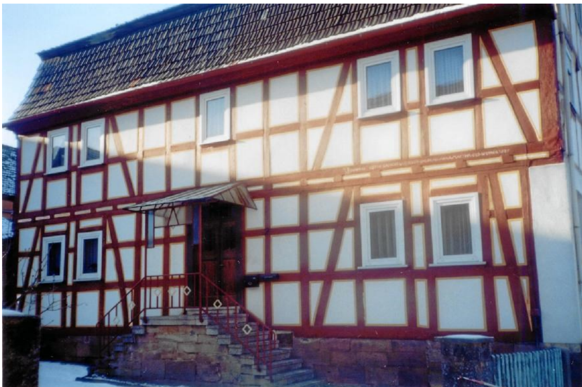
Früheres Wohnhaus Johannes Kothe (heute Hof G. Laufersweiler), an dessen Gebälk die Inschrift: „Johannes Kothe, Bauherr und dessen Ehefrau Anna Martha, geb Werner. 1825 angebracht ist.“
