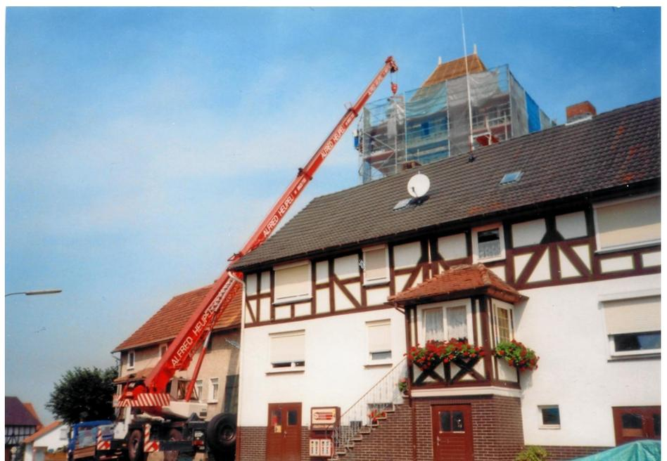
Die Arbeiten am Turmdach konnten nur von einem Kran aus ausgeführt werden
