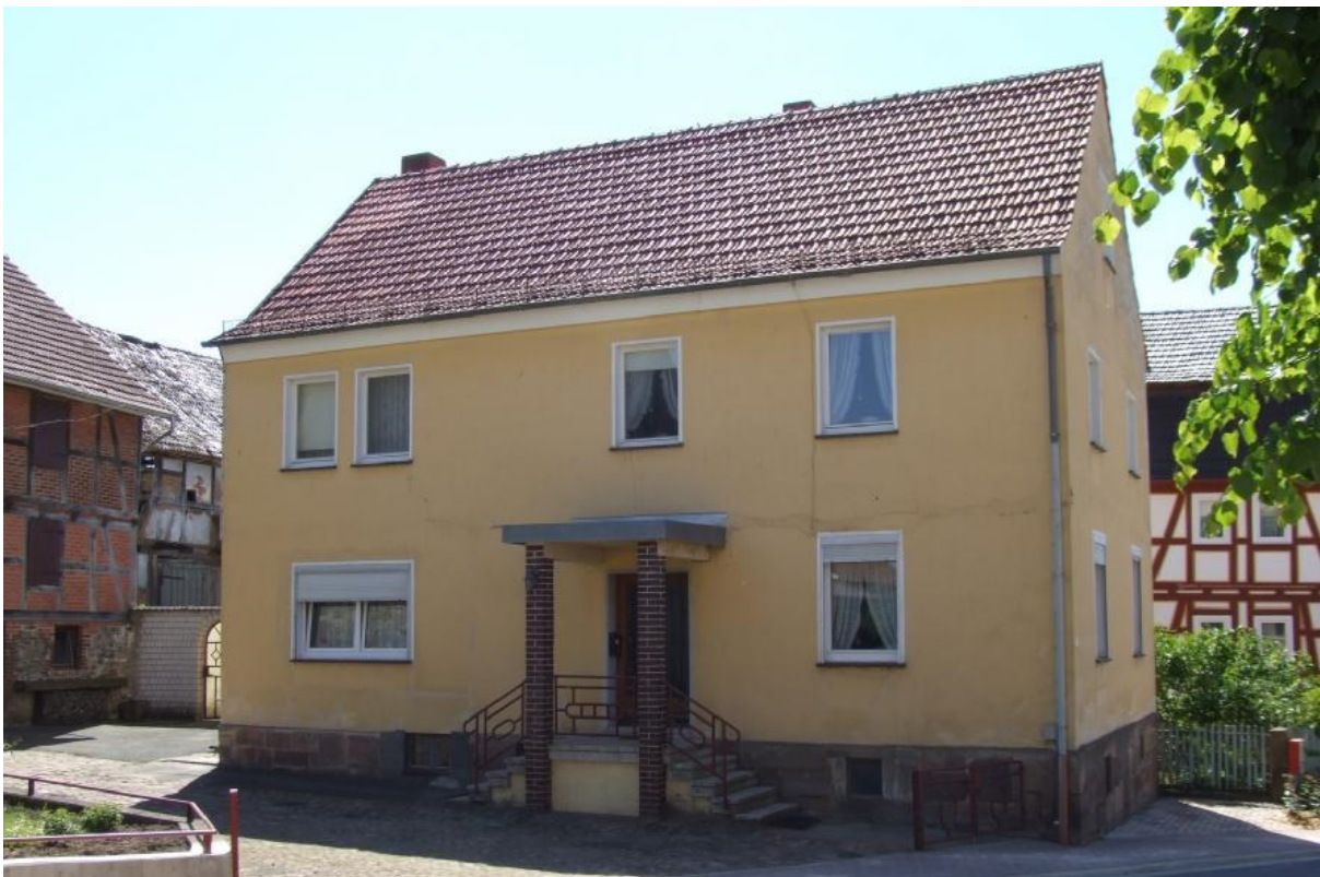
Wohnhaus Lückert. „Das Rathaus“ von Dagobertshausen. Hier tätigte er auch die Amtsgeschäfte mit der Gemeinderechnerin Gertrud Berger.
