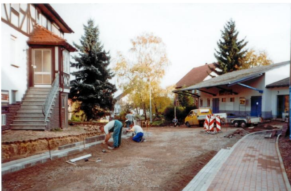
Pflasterarbeiten für die Gehwege und die Asphaltierung der Straße an der Einmündung „Hornberger Weg“ zur Malsfelder Straße.
