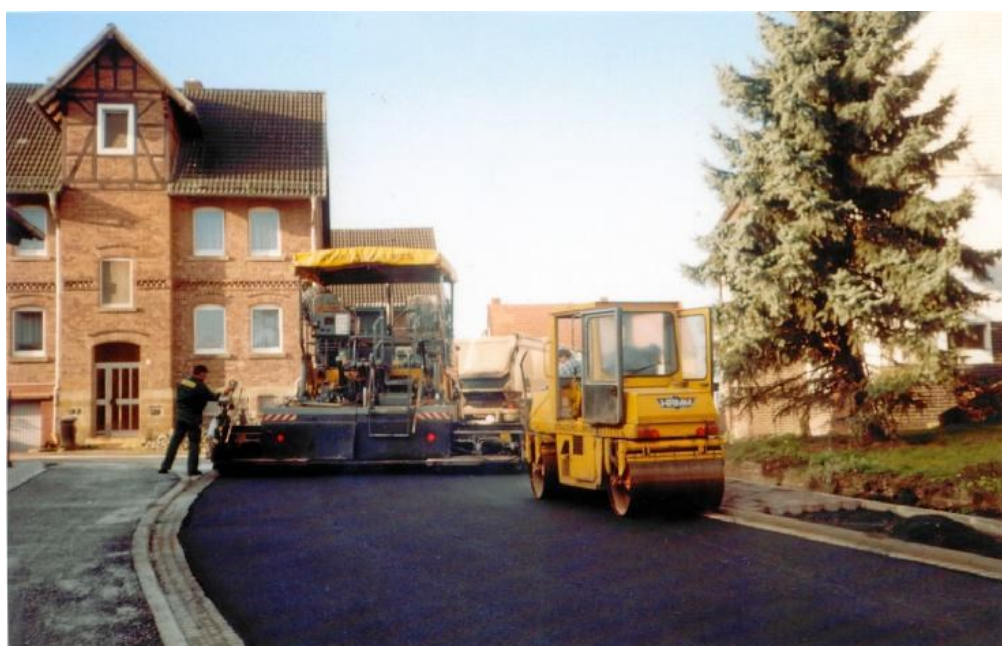
Der Deckenfertiger oder Teermaschine im Einsatz.
