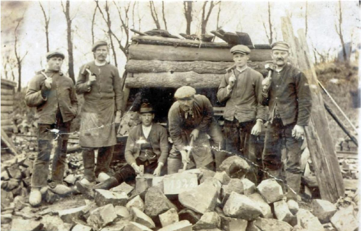
Auf dem oberen Foto werden die großen Basaltsteine erst zerkleinert und dann in drei Größen gefertigt. Auf dem Foto aus dem Jahr 1929 links der junge Ernst Limpert, in der Mitte mit Hammer Ludwig Schaub und rechts Heinrich Alter sen.
