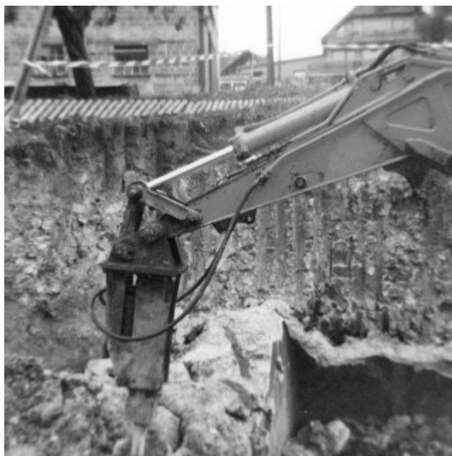
Abriss der Wasserzisterne auf dem Grundstück „Hinter der Kirche 2“, im Sommer 1982
