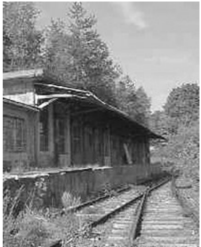
„Restgebäude“ der Munitionsfabrik Hirschhagen bei Hessisch Lichtenau/ Fürstenhagen
