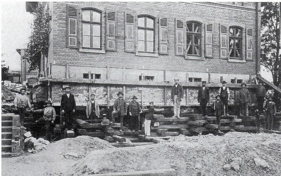
Umsetzung des kompletten, ehemaligen Bahnmeisterhauses wegen Bau der sog. Hochbahn (Verbindung zwischen den Bahnstrecken Kassel-Bebra und Eschwege - Treysa) um 1905, von einer Straßenseite zur anderen (heute Haus Waskönig)
