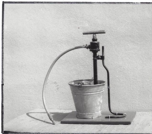
**Handpumpe zum Löschen von Bränden durch Luftangriffe. Wurde ebenfalls nach der Besetzung nicht mehr benötigt.**
