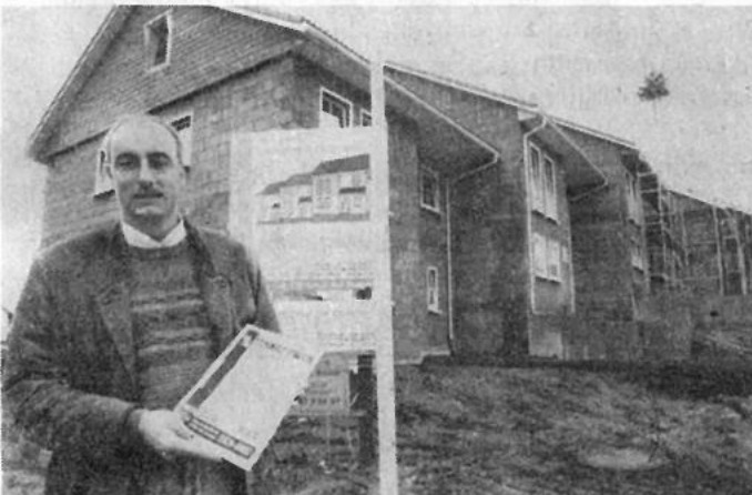
Herr Georg Labusch vor dem Rohbau der Reihenhäuser.
