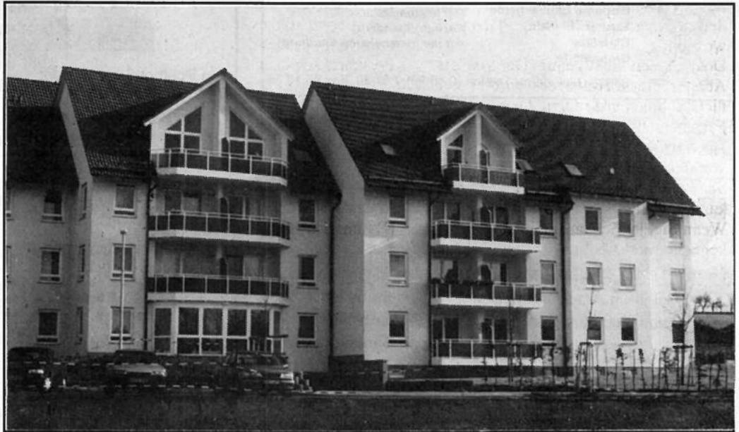
Schon in Betrieb: Haus 1 mit Café, Krankengymnastikpraxis und ambulantem Pflegedienst
