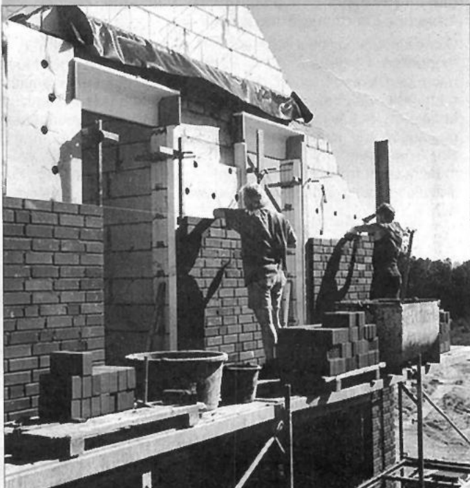
Beim Bau einer zweischaligen Wand mit Backstein wird das Dämmmaterial angedübelt und nicht verklebt.
