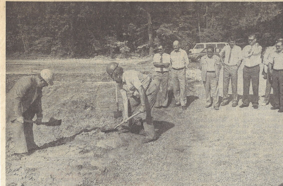
DEN ERSTEN SPATENSTICH für die Malsfelder Kläranlage vollzogen, am Mittwochnachmittag Bürgermeister Kurt Stöhr (links) und der Vorsitzende des Bauausschusses, Wilhelm Schwarzenau. - (Foto: nh)
