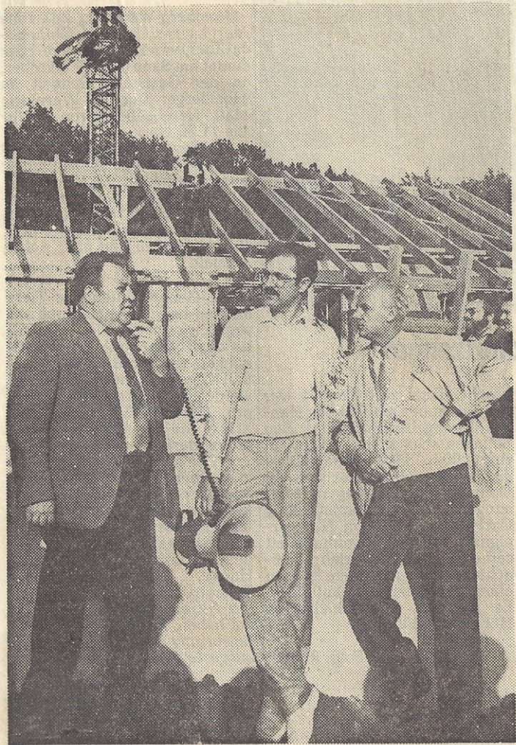
DER RICHTKRANZ wurde am Donnerstagnachmittag mit Hilfe eines Kranes über dem Betriebsgebäude der Malsfelder Kläranlage gerichtet. Zimmermann Peter Reichl sprach den Richtspruch. Vorn im Bild von links: Bürgermeister Stöhr, Willi Thierolf von der Gemeindeverwaltung und Beigeordneter Werner Ploch.
