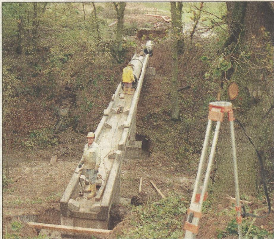
ke. Die Rohre bestehen aus Leichtbeton, das führt zu einer veränderten Statik, die weniger aufwendig ist. Die ganze Brücke besteht aus Fertigteilen. Außerdem spart die Gemeinde durch Eigenarbeit des Bauhofs. Das Dach über die Brücke von einer Firma installieren zu lassen, hätte inklusive Material 35 000 Mark gekostet, statt des-
