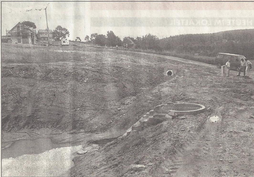
*Ein Rückhaltebecken im Neubaugebiet zwischen Malsfeld und Beiseförth sorgt dafür, daß Oberflächenwasser nicht in die Kanalisation läuft.*
