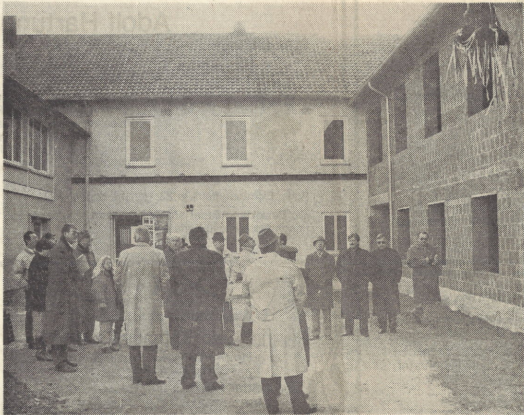
DER ANBAU an die Malsfelder Grundschule (rechts im Bild) ist im Rohbau fertig, gestern vormittag wurde Richtfest für das 2,1-Millionen-Projekt gefeiert. Weil der Altbau aus allen Nähten zu platzen drohte, entstehen jetzt unter anderem vier neue Klassenräume. (Foto: hro)
