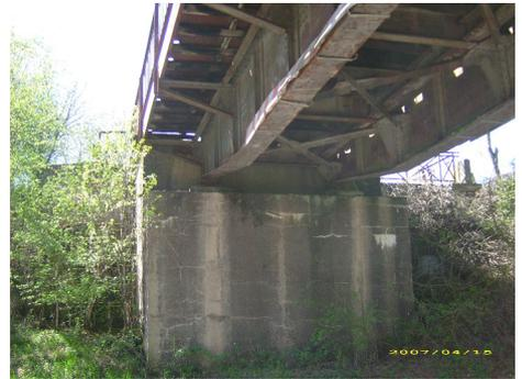
Das Widerlager B (Ri. Malsfeld) mit einem Teil der Stahlkonstruktion um 2000 (Sg. R. Trumpik)
