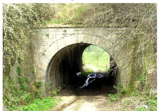
läuft die Trasse noch für ca. **150 m** über den Damm, bevor sie für eine längere Strecke hinter einem Bergvorsprung erneut in einem Einschnitt verschwindet, in dem bei **Km 81,85** am Südhang die Reste einer Wasserabfluss-Rinne sowie einer Stützmauer erhalten sind. Aus dem Einschnitt heraus führt die Strecke am Südhang
