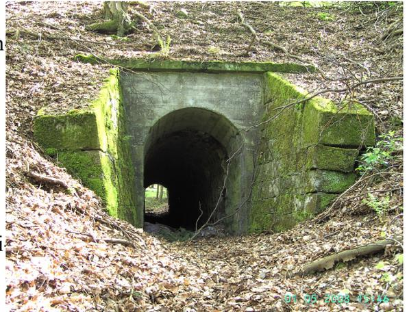
Das mit Beton ausgegossene Nordportal der Unterführung am 1. 9. 2008
