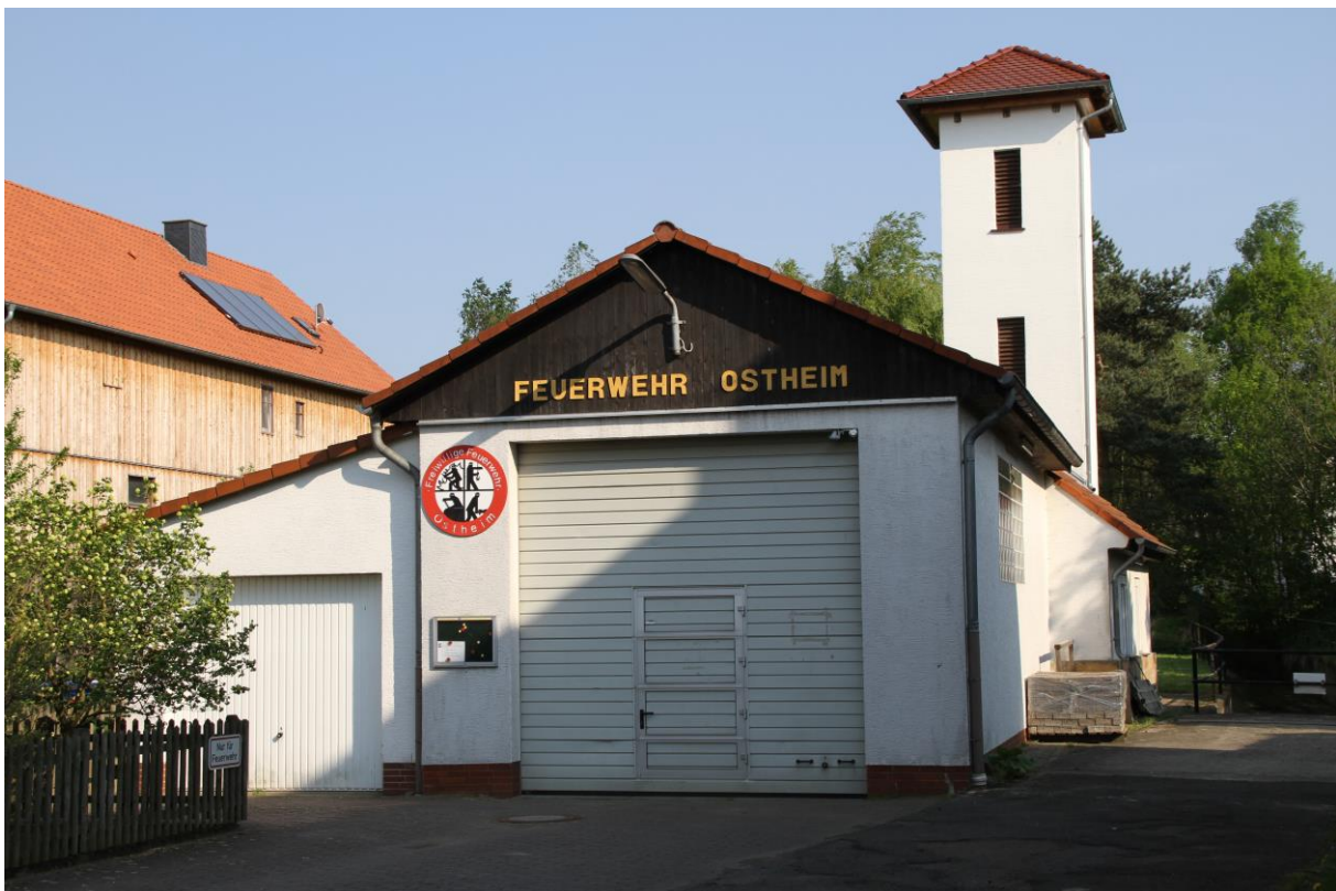
Feuerwehrgerätehaus nach mehreren An- und Umbauten im Jahre 2011
