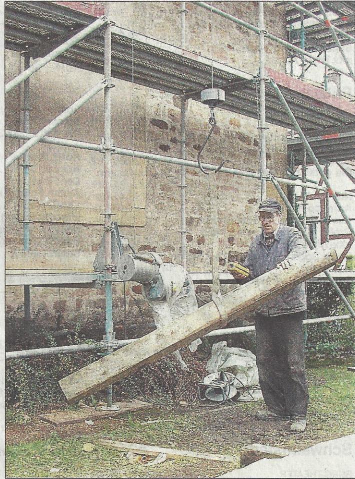
Zugemauert: Das Fenster in Mauer der Sipperhäuser Kirche, derzeit nur durch den Sandsteinrahmen erkennbar, soll wieder geöffnet werden. Hier Zimmermeister Bernd Habermehl bei der Arbeit FOTOS: HOCKE
