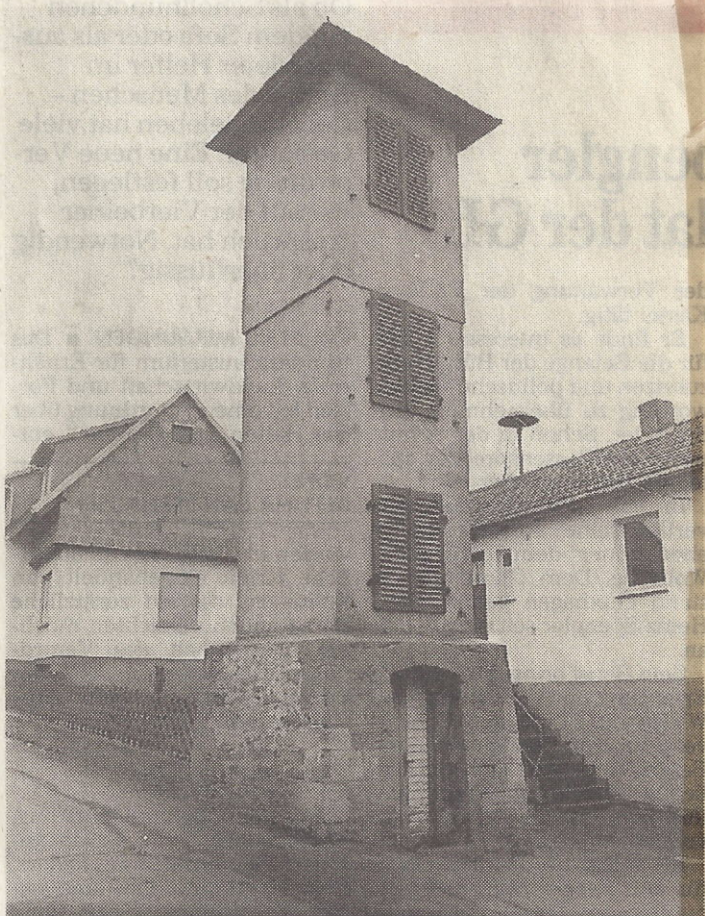
Der alte Sipperhäuser Schlauchturm soll beim nächsten Aktionstag im Sommer renoviert werden. (Foto: Lorenz)
